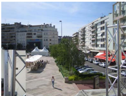
Figure 5 - Vue du mat et de son antenne sectorielle (vue de détail à 90° de l'antenne en insertion en bas à droite)
